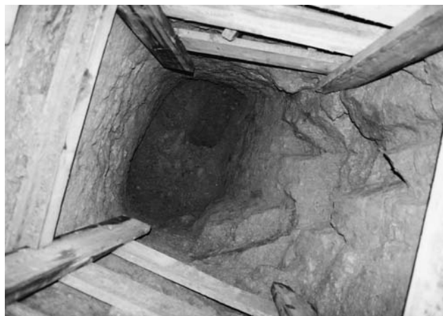
Foto 14. Jihlava - Staré Hory. Průzkumná šachta v interiéru stavby 1622 v úrovni dna (archiv ARCHAIA Brno). — Foto 14. Jihlava - Staré Hory. Prospektions-Schacht im Inneren des Gebäudes 1622 auf Bodenhöhe (Archiv ARCHAIA Brno).
